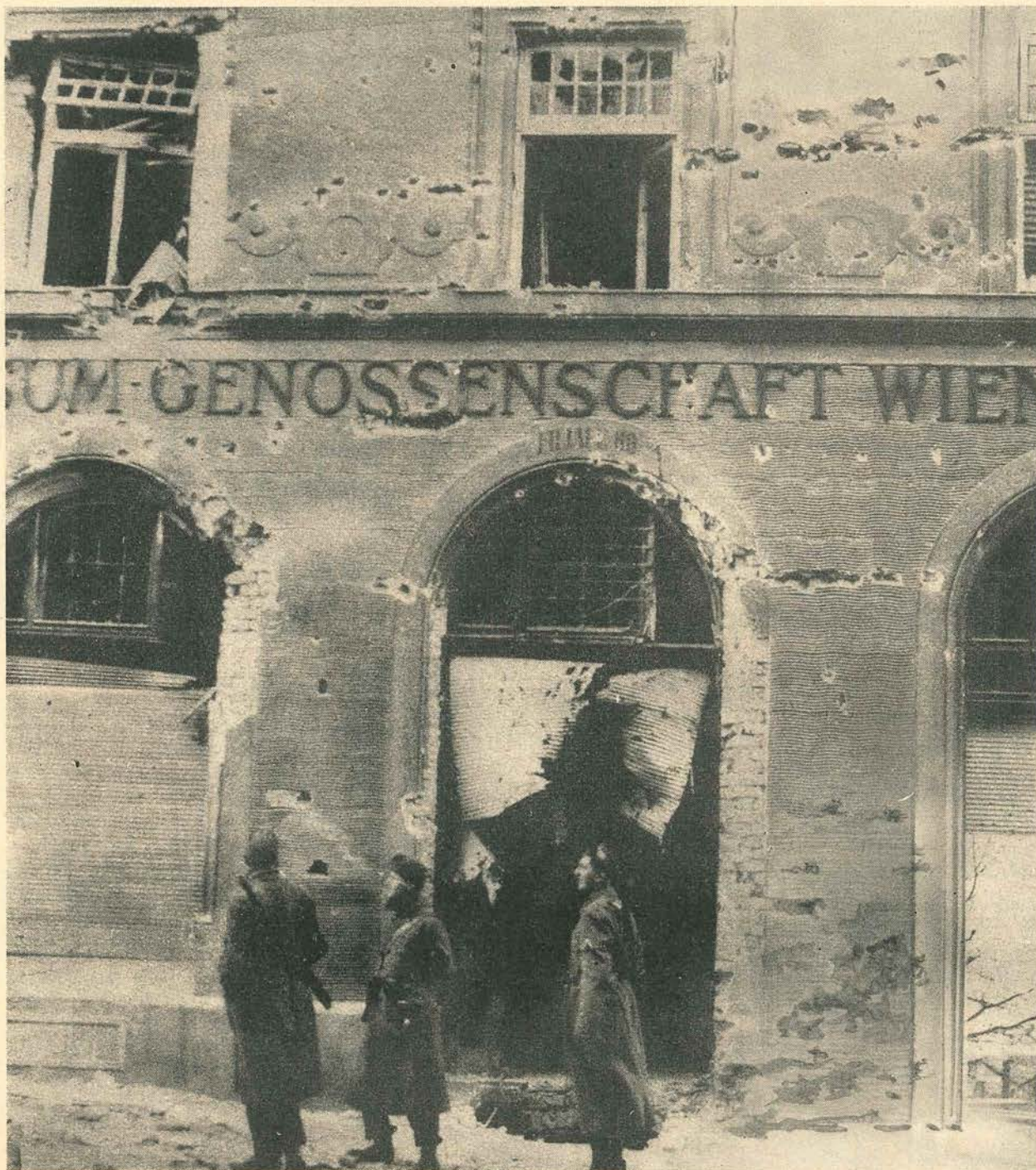
Vor dem durch MG- und Geschützfeuer zerstörten Ottakringer Arbeiterheim, um das tagelang gekämpft wurde.
