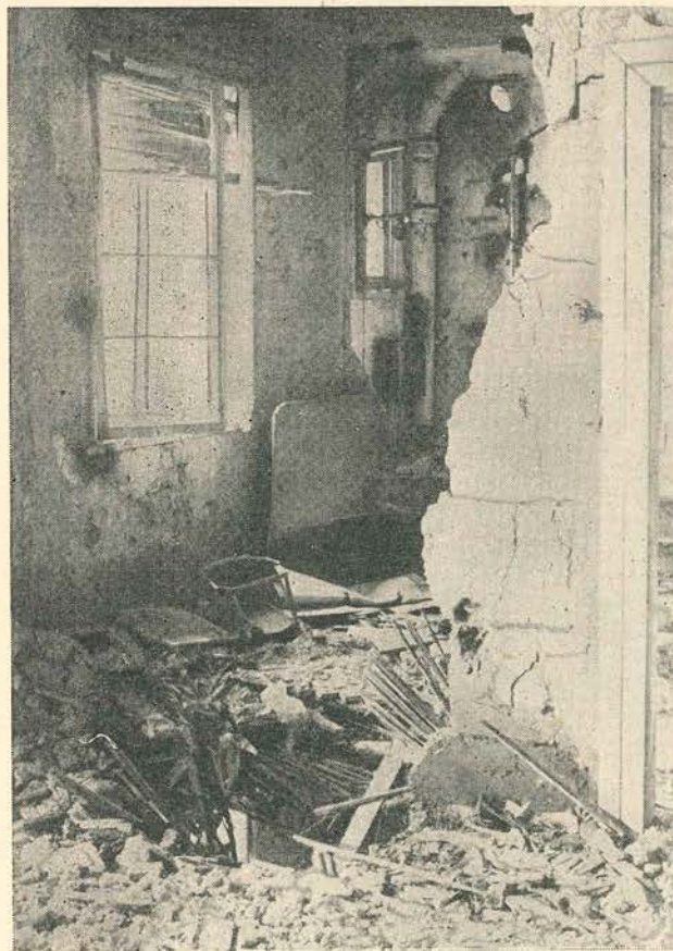
Eine zerschossene Wohnung im Goethe-Hof.
